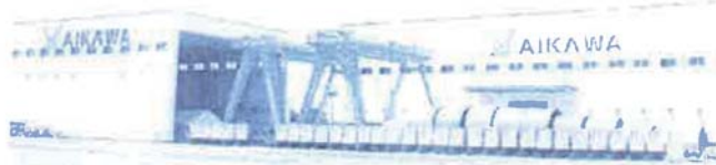
風力発電タワーを製造する会川鉄工の新工場
